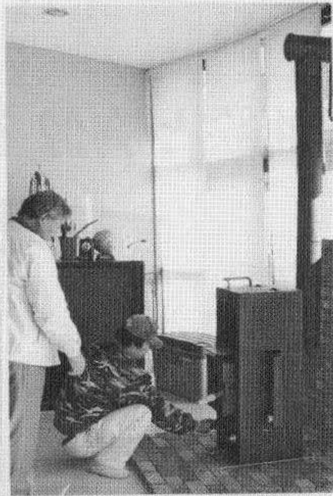
和田コミュニティセンターに 設置されたペレットストーブ
