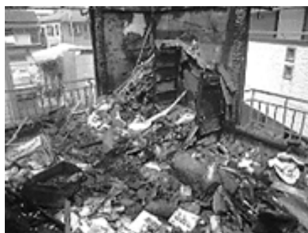
写真1 大量の焼損物
