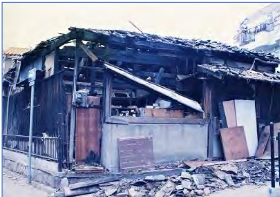
写真3 飛び火による家屋の焼損状況
