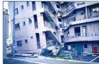
写真 追-1 耐火建物の倒壊 下層部の座屈が全体に影響
