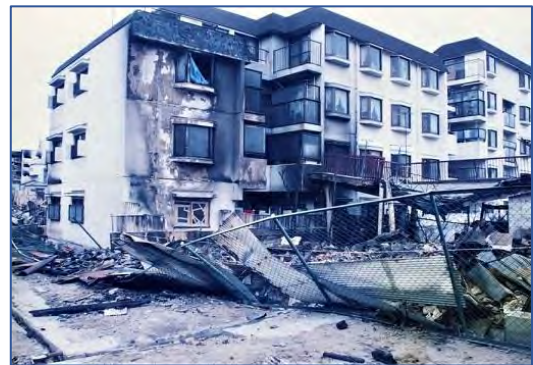
写真4 マンションの焼損部から見た飛び火
