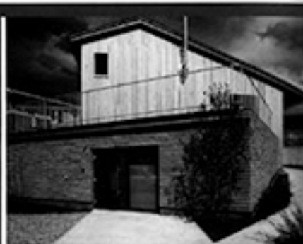
道路側西外観
