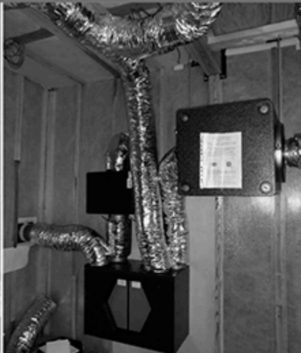
ヒートパイプを組み込んだ熱交換換気システム。
