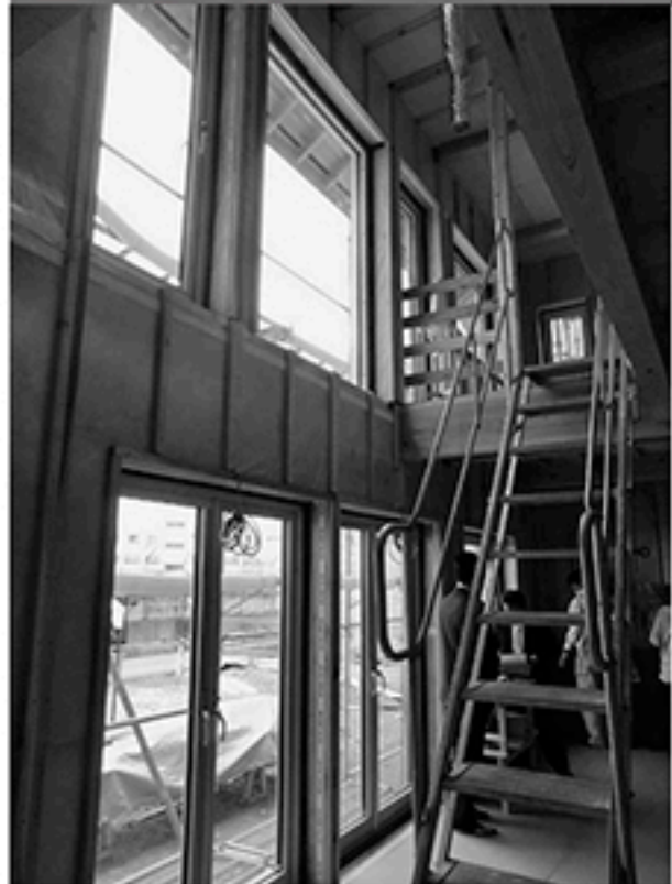
配気の配管スペースを確保した壁下地。
