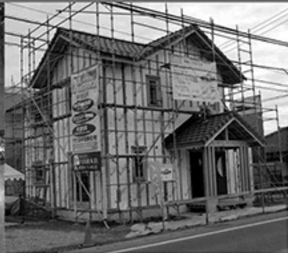
外壁材仕上げ前の外観。
