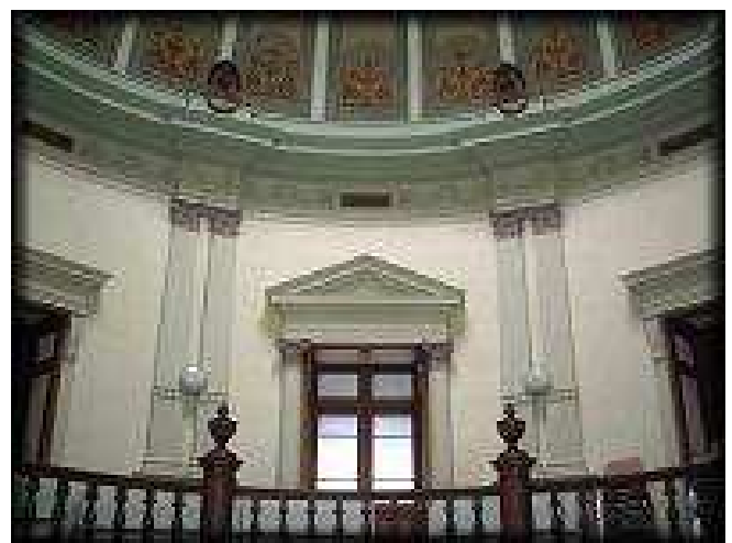
【中央ホール内部】
