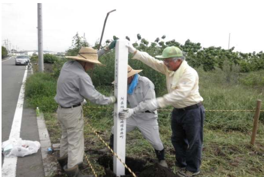
看板設置作業
