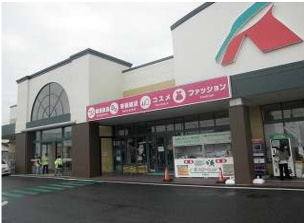
東出入口付近での調査
