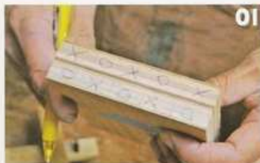
01 材の木口を5分割する墨線を引き、交互に○×の印を入れておく。ピギナーのうちは墨線は均等に引くとわかりやすい
