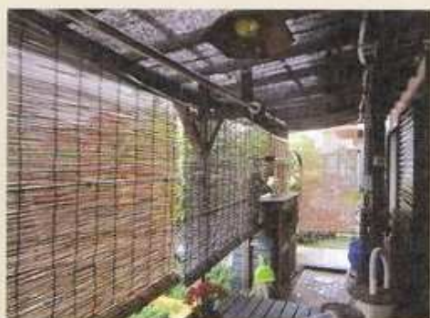
屋根に寒冷紗を載せて、すだれをセットした状態
