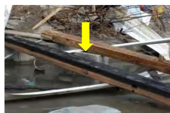
写真 21 魚市場前路上に合ったとして掲載されている、半分焼けた柱。上側のみの焼損。
