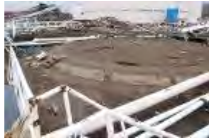
写真 32 屋外タンクのあった油槽所の土盤
