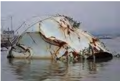
写真 29 流出し、河川の河口に横たわるタンク
