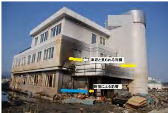
写真 22 焼損した内の脇地区弁天町の外科医院
