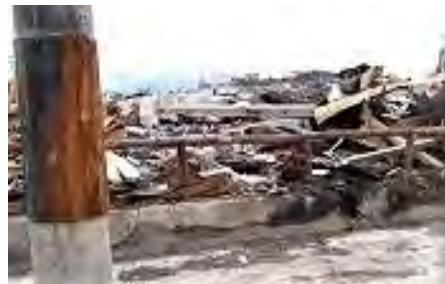
写真9 公園の外周部に見られる地盤付近の焼損痕跡
