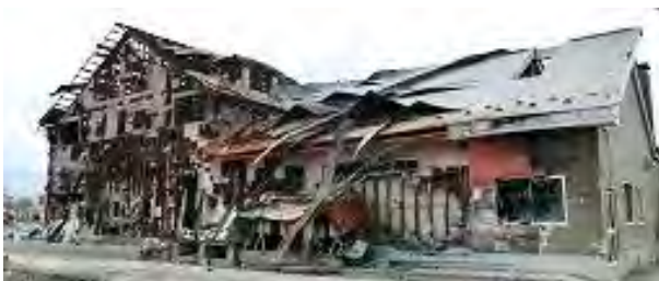
写真8 内の脇 2-23「湯みえーる」の焼損、破損状況
