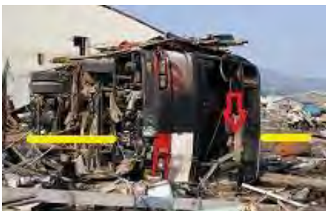
写真15 鹿折地区内の横転したバスの焼損状況
