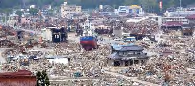
写真6 鹿折地区一帯、南から北方向を見る
