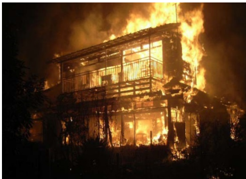
写真 k203-1 炎上中の建物火災
