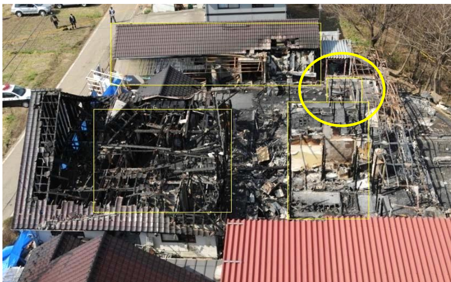
写真 k311-1 火災建物の外観 (○印は出火個所 付近として図示し た、この頁で記載)
