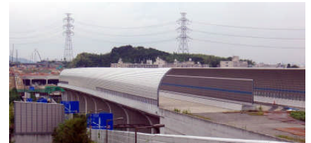
来春に全線開通予定の第二京阪道路
