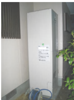
エコキュート(高効率給湯器)を設置したところ
