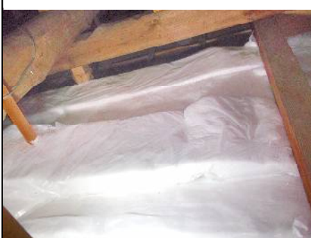
床・壁・天井に断熱材を取り付けます。↑ ↓ ↗ ↘
