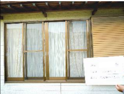
↑エコガラスに取り替え。 窓から伝わる冷気や熱気を遮断し、暖房・冷房の効果をアップします。次世代省エネルギー基準適合。
