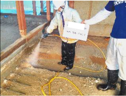
↑防腐・防蟻工事。 劣化を防ぎ、長持ちする家になります。
