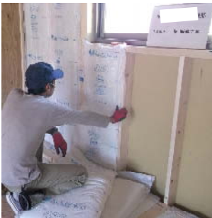
↑断熱材を取り付け。 高性能のグラスウールを採用しています。床・壁・天井に取り付けます。
