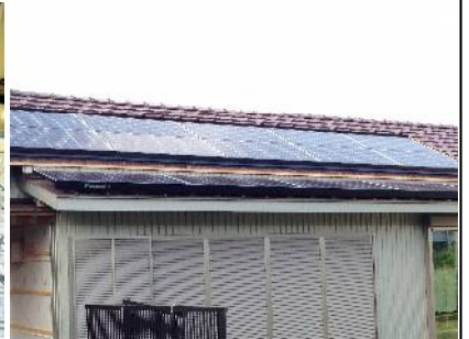
↑屋根瓦の葺き替え 劣化対策だけでなく、軽い屋根材に替えることで耐震強度のアップにもなります。太陽光発電も取り付けました。
