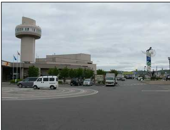
道の駅「サラブレッドロード新冠」
