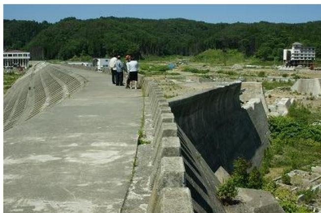
しかし今回の津波は 10mの高さを優に超え、その力は自慢の防波堤を簡単に乗り越え、破壊し、町を壊滅させた。残った堤防の上から惨状を眺め、町役場を表敬慰問した。
