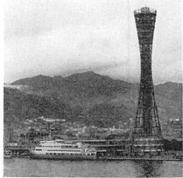
神戸ポートタワー
