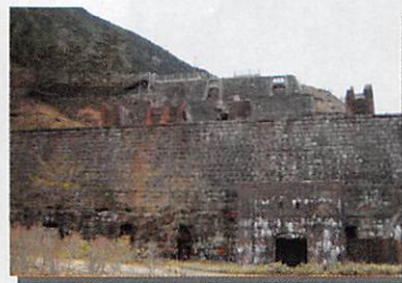
貯鉱庫下にある東平索道停車場の遺構
