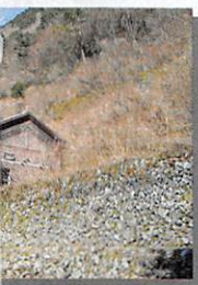
東平第三変電所建屋
