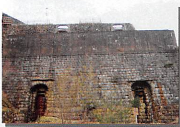
重厚な花崗岩造りである東平貯鉱庫の遺構
