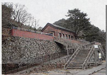
メイン工房として再生された旧保安本部建屋
