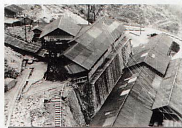
稼働中の東平索道停車場
