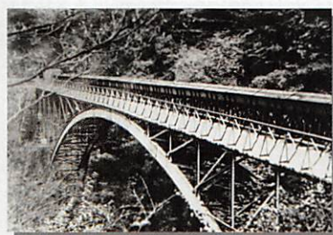
落シ橋には、かつて坑水路が併設されていた
