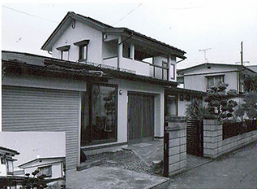
改修後の外観 (太陽光発電のため、屋根勾配を急にした)。
