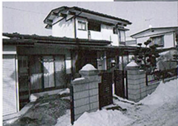
改修後の外観 (太陽光発電のため、屋根勾配を急にした)。
